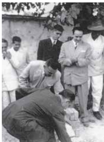
Foto 6 - Lançamento da Pedra Fundamental da construção da sede do CR-C-MT, em 2 de setembro de 1956.
