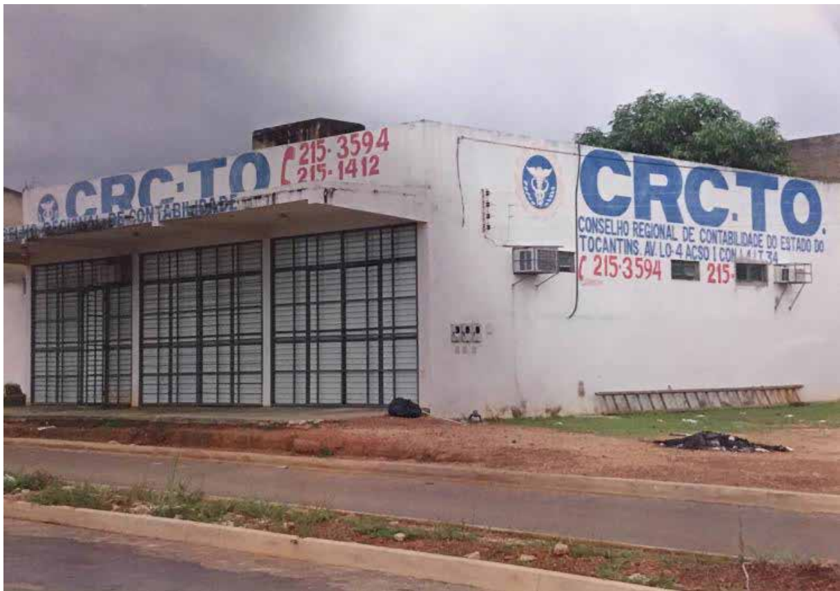
Figura 8 - Imagem da fachada do prédio da 1ª Sede CRC-TO, no período de 1998 a 2002.
