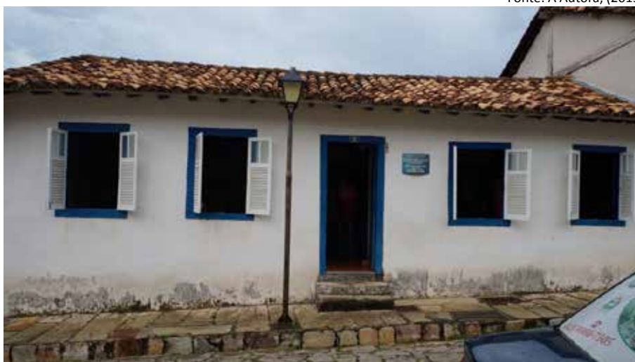
Figura 10- Fundação Frei Simão Dorvi
