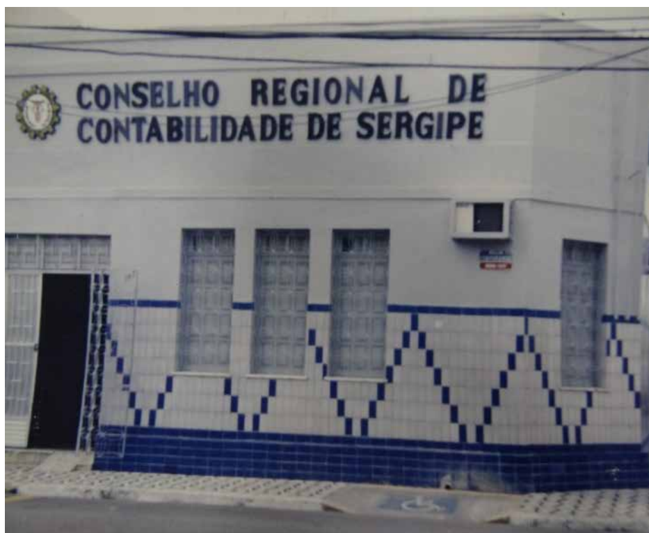
Figura 16 - Terceira sede reformada, Rua Itaporanga.
