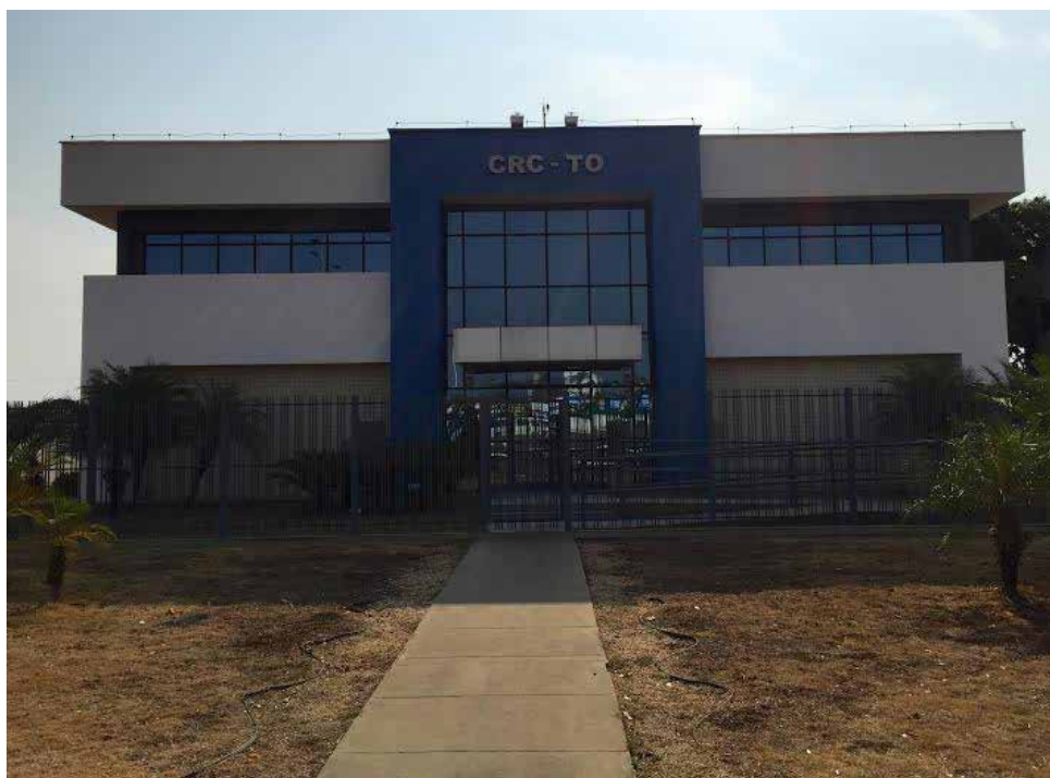
Figura 10 - Imagem da fachada do prédio da 3ª Sede do CRC-TO inaugurada em 2009, local onde se encontra o CRC-TO atualmente.
